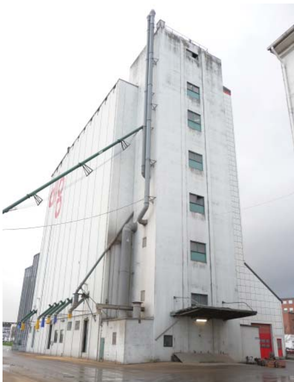
Kongensgade 4 udgør et karakteristisk eksempel på 1950'ernes og 1960'ernes silobygninger.
