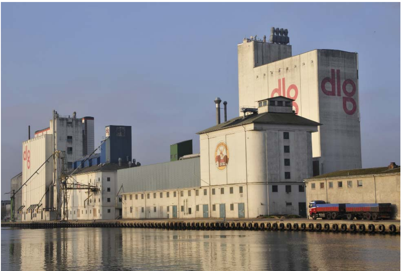
DLG-silopakhusanlæg ved Randers Havn.
