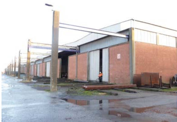
Tronholmen III med kranskinnesystem mod kajgade.
